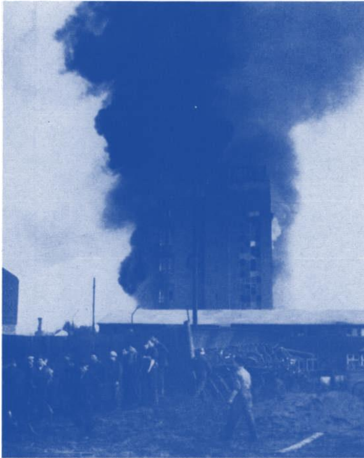
Kugelfischer 17. Oktober 1943. Hochbau
