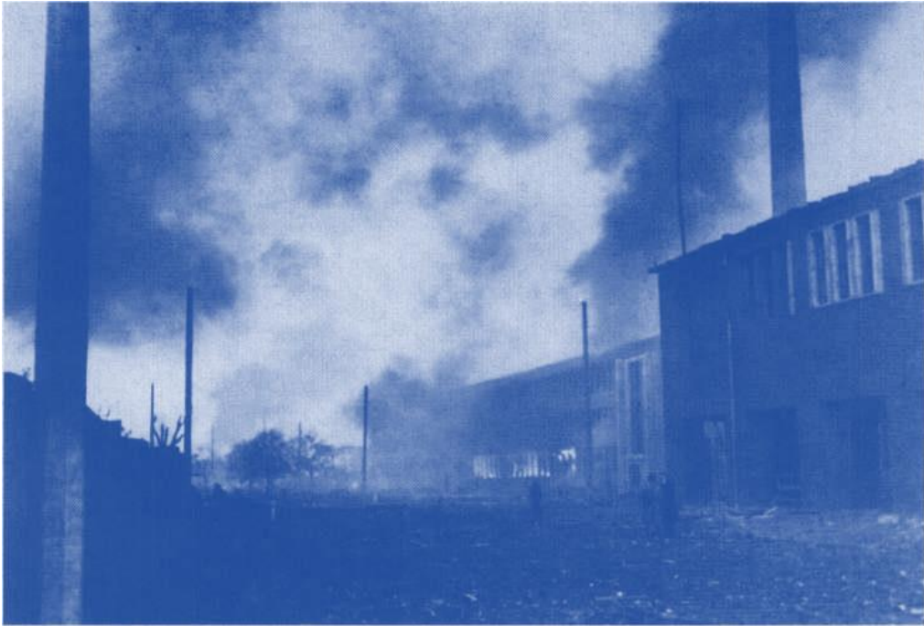
Kugelfischer 14. Oktober 1943. Labor- und Verwaltungsbau an der Georg-Schäfer-Strasse
