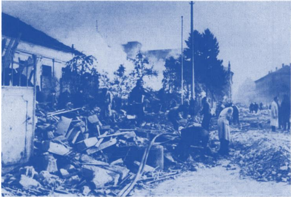
Vereinigte Kugellagerfabriken 15. Oktober 1943. Werk I, Schulte-Strasse. Lösch- und Aufräumarbeiten
