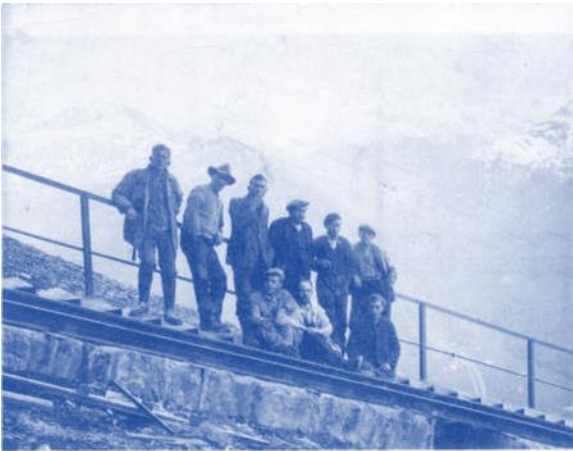
Arbeitslose im Mai 1932 beim Bau der zweiten Teilstrecke der Parsenn-Bahn in Davos. Walter Wagner (stehend zweiter von rechts) erhielt die Stelle durch das St. Galler Arbeitsamt. (Nachlass Wagner)
