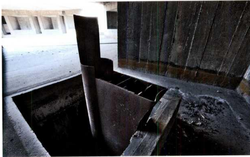
Kettenaufzug für die Flakgranaten im Geschützturm Arenbergpark.
