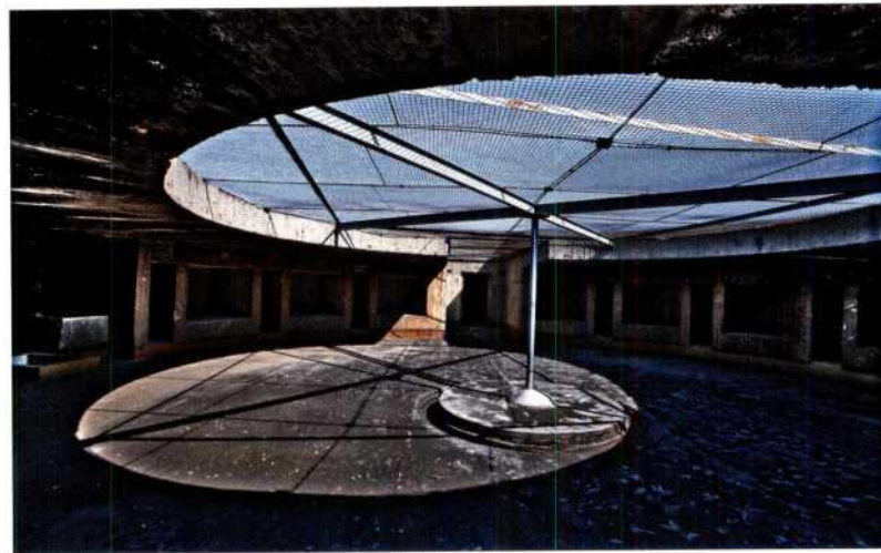
In einer der vier runden Geschütz- stellungen, Standort der 12,8-cm- Zwillingsflak
