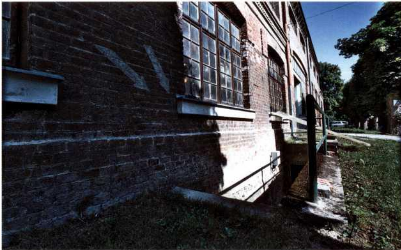
Hinweisfeile zum Abgang in den Luftschutzkeller.
