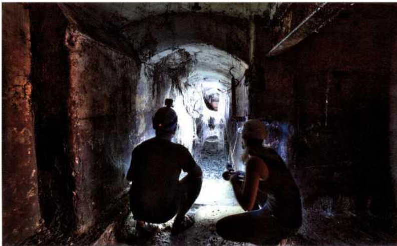
Durch diesen heute unter Wasser stehenden Gang wurden einst die einzelnen Werkshallen mit Energie versorgt.
