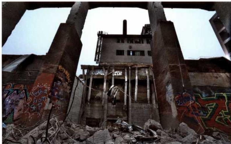
faszinierende Industrieruine: Das still gelegte Zementwerk in Kaltenleutgeben.
