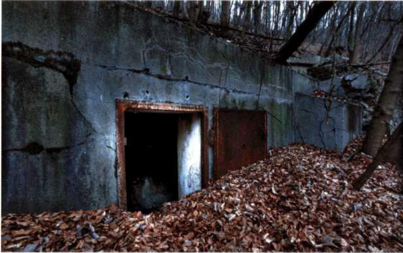
Eingang in den LS-Unterstand für Bahnarbeiter.
