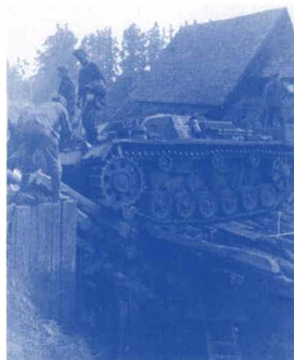
Viele untergelegte Holzbalken ermöglichen eine Überwindung des Grabens.
