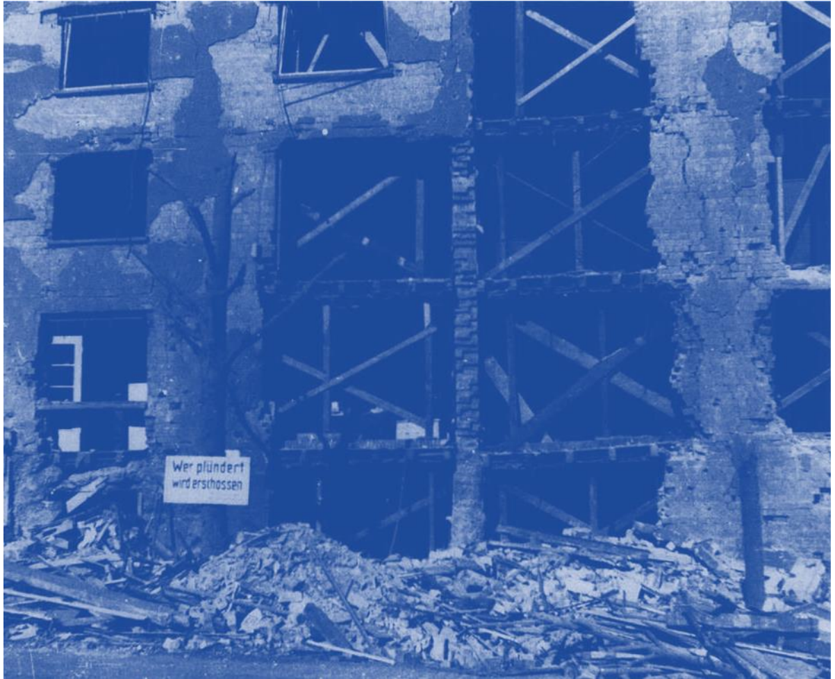
89 «Schlupfwinkel lichtscheuer Elemente» (Strölin): Probleme in der Sperrzone
