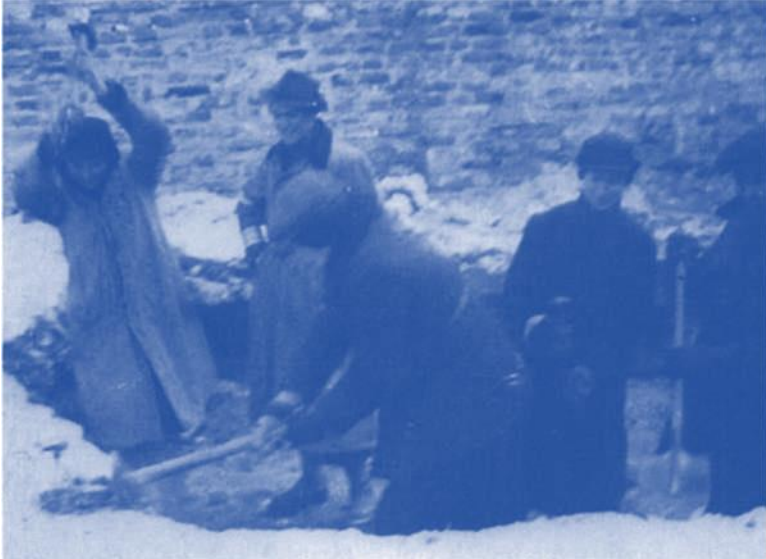
Romek Kowalski überwacht den Bau der Chettomauer
