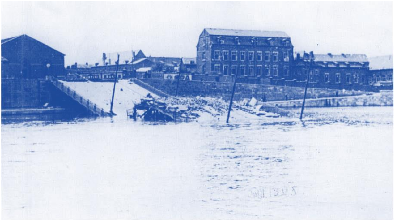
Die gesprengte Maasbrücke in Lüttich.
