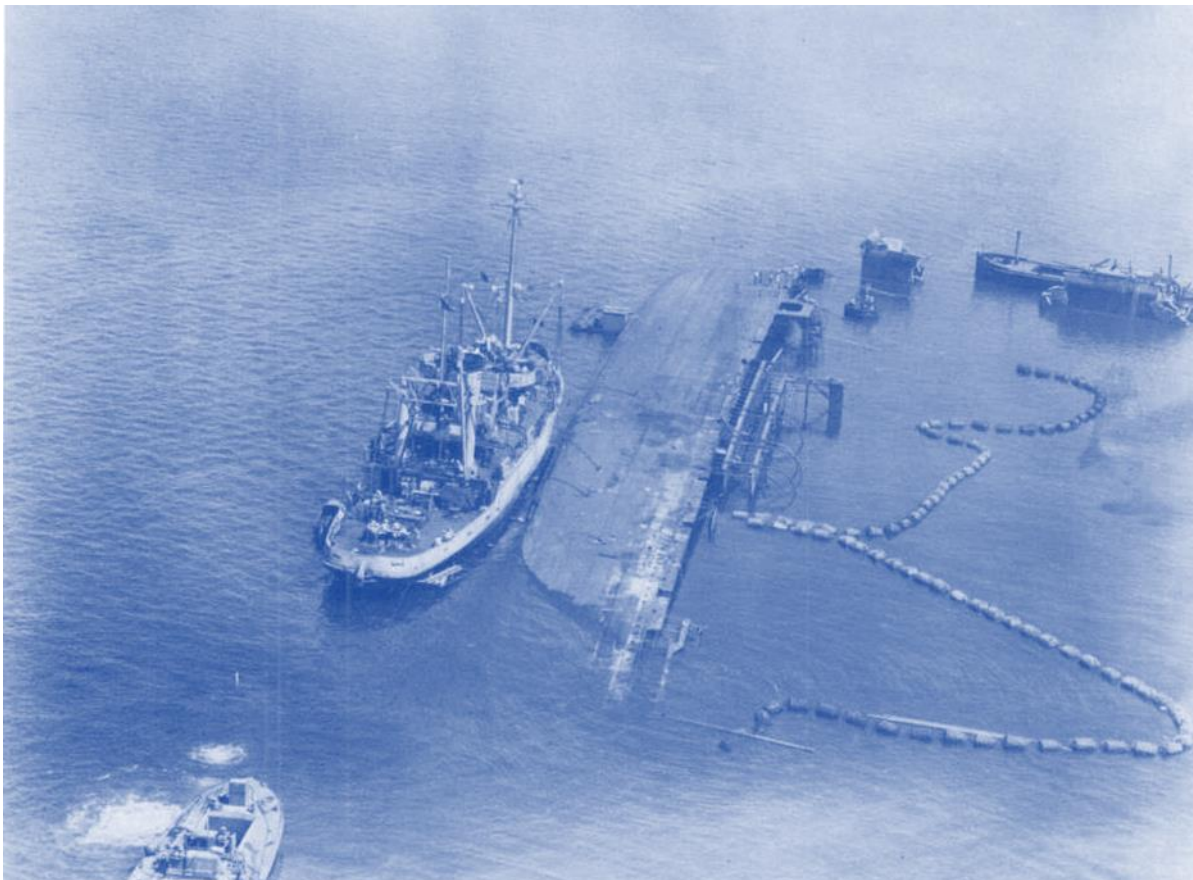
Ein Schiff der US-Marine macht an einem gekenterten 170 Meter langen Walfänger fest, mit dem später ein Pier verlängert wurde.
