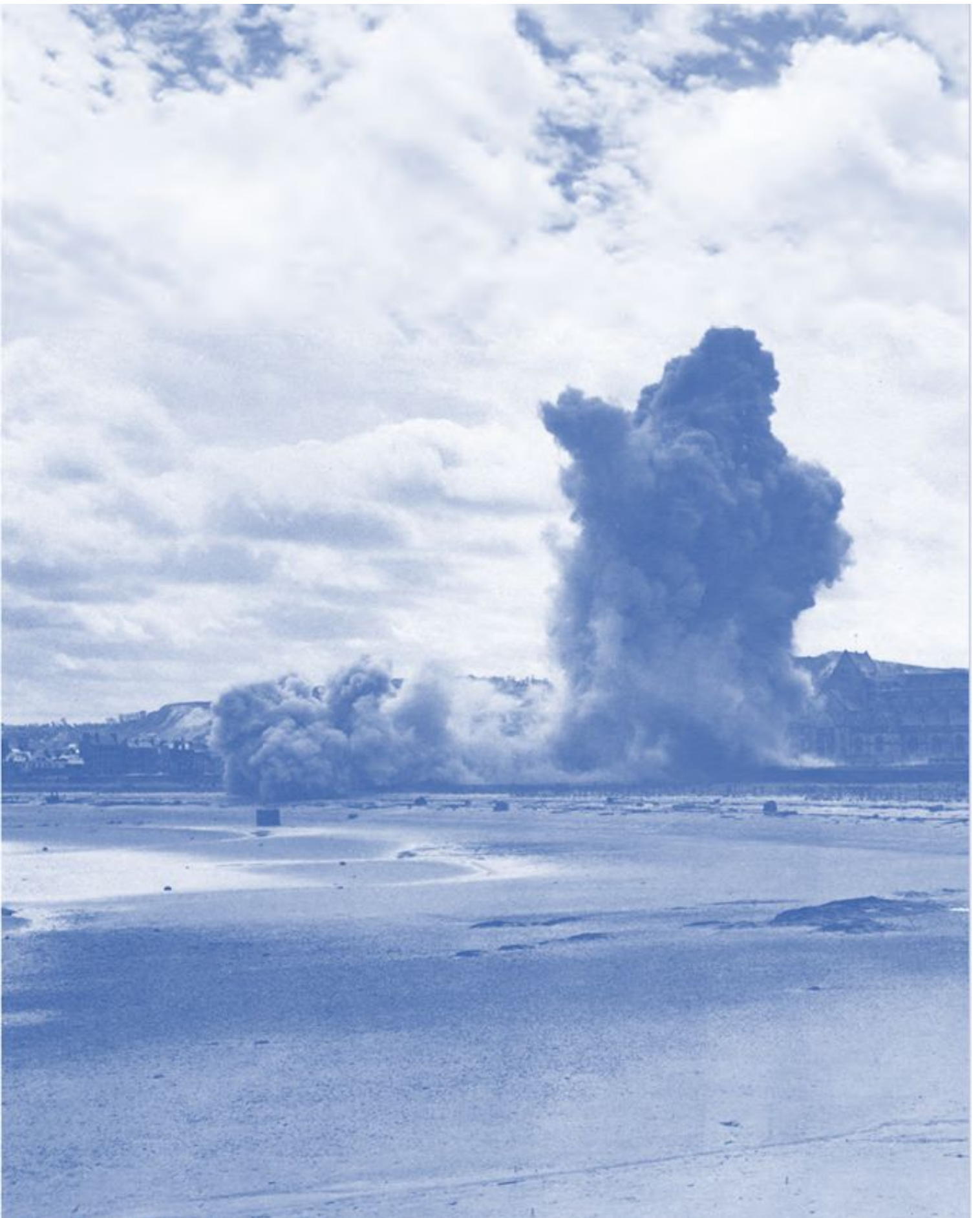
Eine Rauchwolke steigt auf, als US-Pioniere mit Dynamit eine der drei Breschen in die Standmauer sprengen, die eine direkte Anlandung dort ermöglicht.
