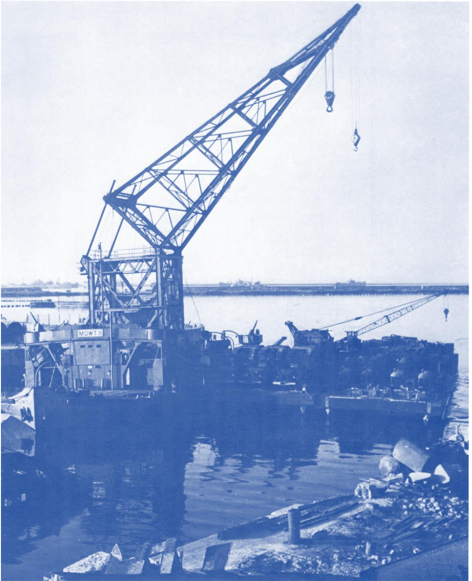
Schwimmkran schwenkt über das Wrack eines 1'500 Tonnen grossen U-Boot-Bergungsschiffs, das den Hafen blockiert. Die Kommandobrücke hat man schon entfernt.
