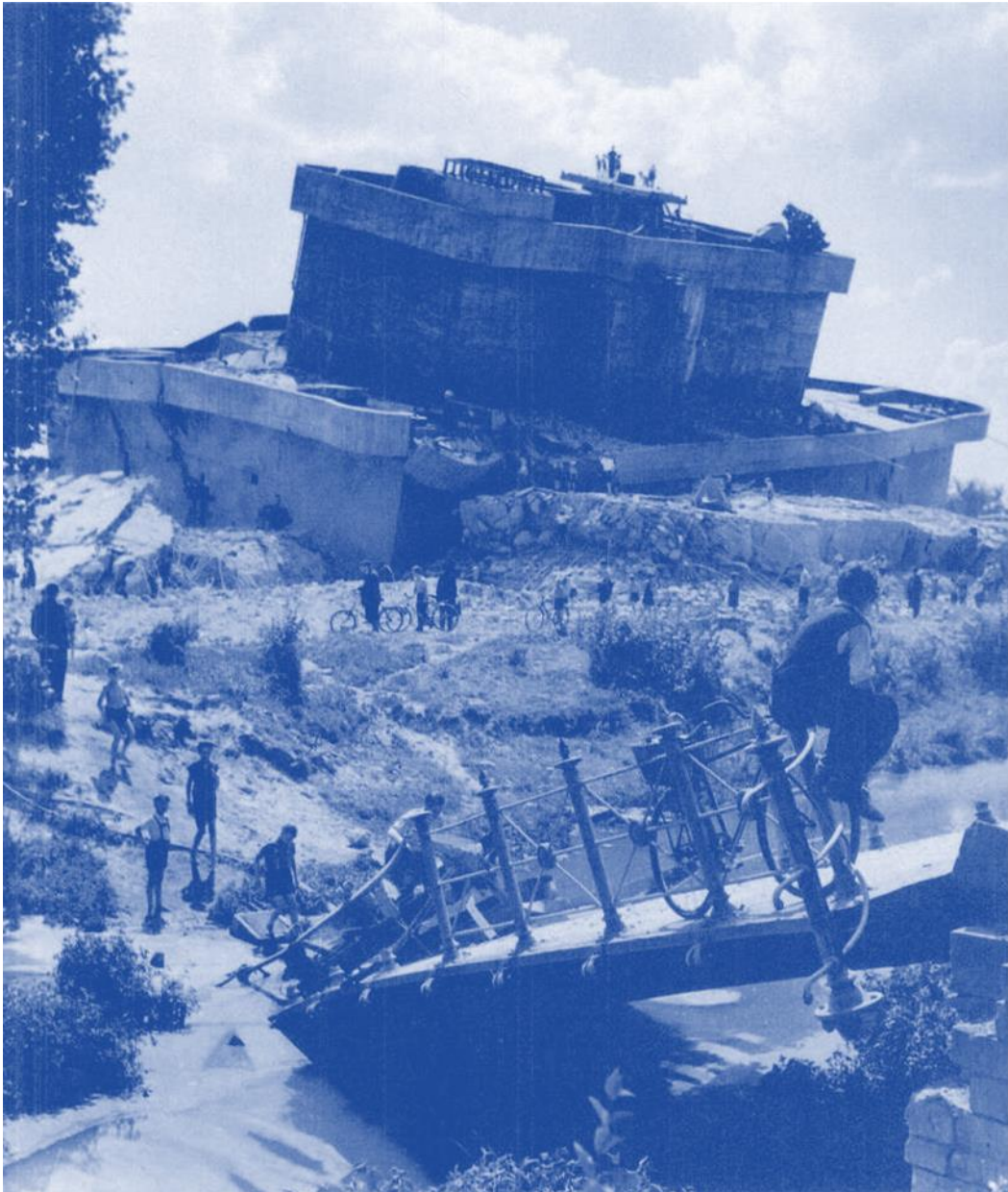
Berlin. Der Kleine Zoo-Bunker nach der Sprengung. 1947 (Nr. 21)
