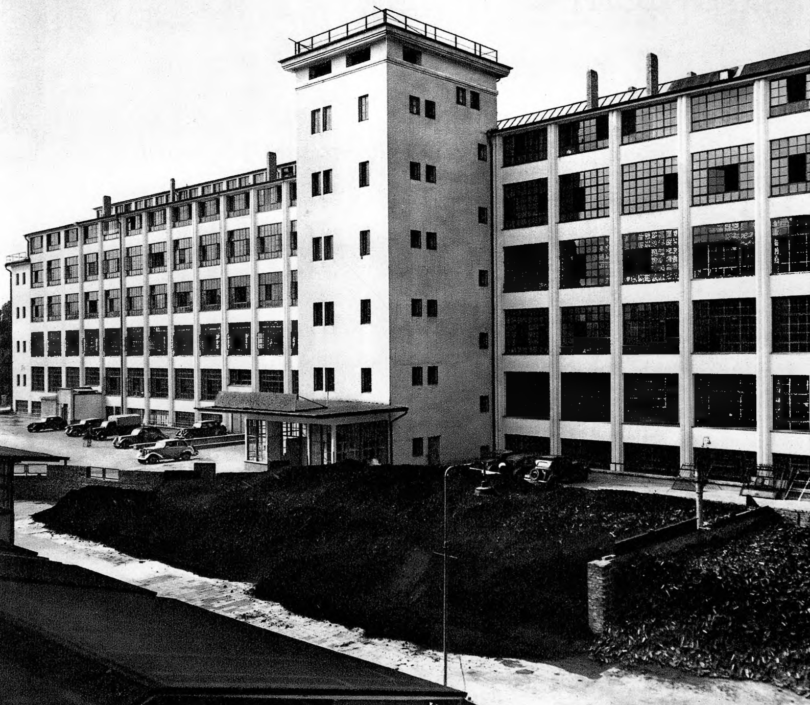
Das waren total ausgebrannte Betriebsgebäude
