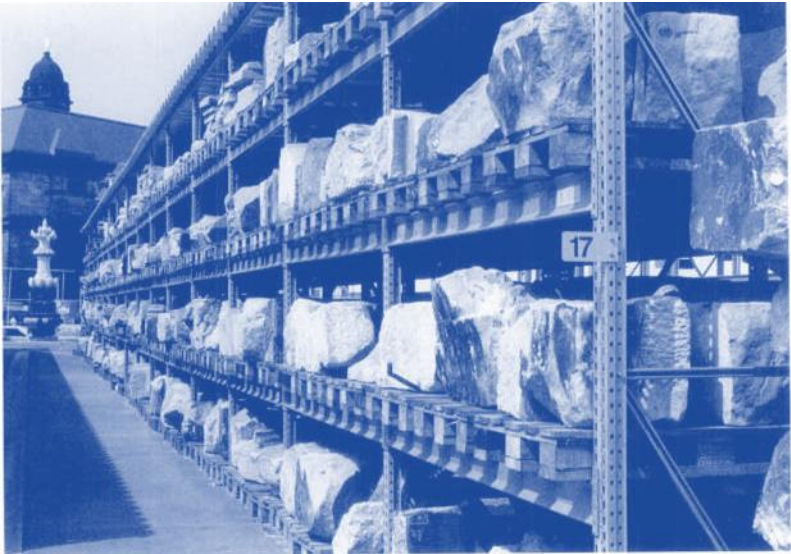
Wiederaufbau der Frauenkirche. Magazinierung der aus dem Schutt geborgenen, wiederverwendbaren Steine (Aufnahme 1994)
