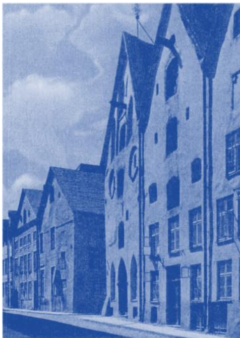
In der Langstrasse in Reval. Im Vordergrund die «Drei Schwestern», drei besonders gut erhaltene Bürgerhäuser, die zu den Sehenswürdigkeiten der alten Stadt zählen. Charakteristisch sind die Flaschenzüge, mit den man die Handelsware in die Speicherräume auf dem Dachboden hinaufzog.
