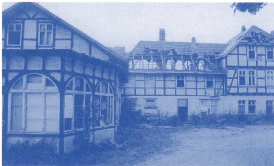
Gaststätte «Landhaus». Die Schäden im Dach des 1993 fotografierten Gebäudes stammen von einem Brand.
