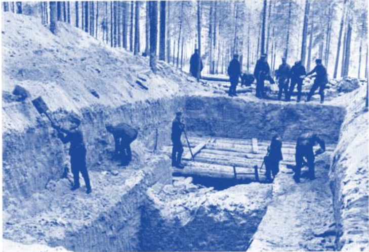
Bau eines Unterstandes. ( Die Erde wird nachher wieder auf die Baumstämme, die hier die Funktion des Dachgebälks ausüben, geworfen.)
