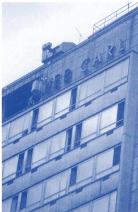
Demontage der Buchstaben VEB am Forschungs- hochhaus.
