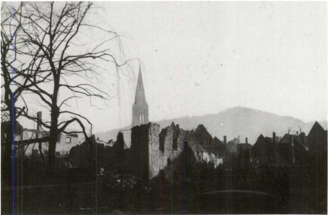
Nach dem Angriff auf Freiburg am 27.11.1944: Aus den Trümmern der Freiburger Häuser mit einer Vielzahl von Kaminstümpfen ragt das Münster hervor.
