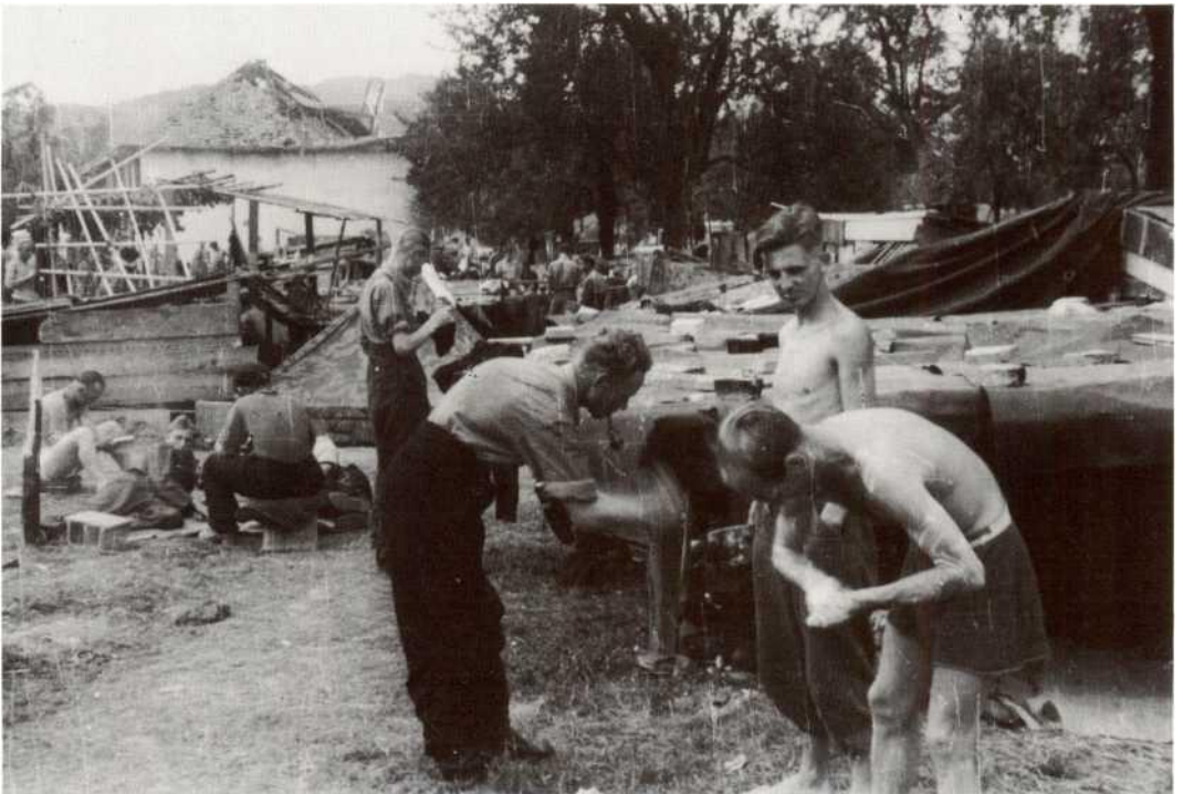
Gefangenenlager bei Linz-Urfar: Soldaten im Wechsel von Herumlungen und Befehl. Unser Lager mit dem durch Steine beschwerten Dach aus Dachpappe, im Hintergrund bauen SS-Angehörige ein Holzhaus.
