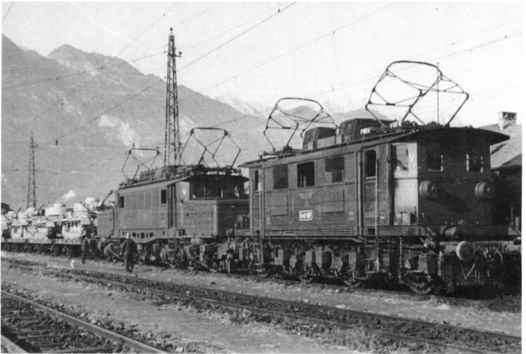
Halt in Innsbruck: Der schwere Transportzug mit doppelter Kraft: Die E-Lokomotiven der Baureihe 45 und 94 ziehen in Kürze gemeinsam den Zug über den Brenner.
