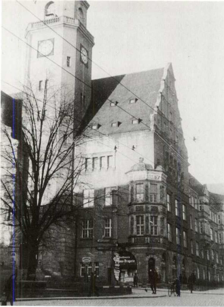
Umzug: Nach dem Fall von Insterburg ist die dortige Dienststelle nach Allenstein verlegt (vor dem Rathaus).
