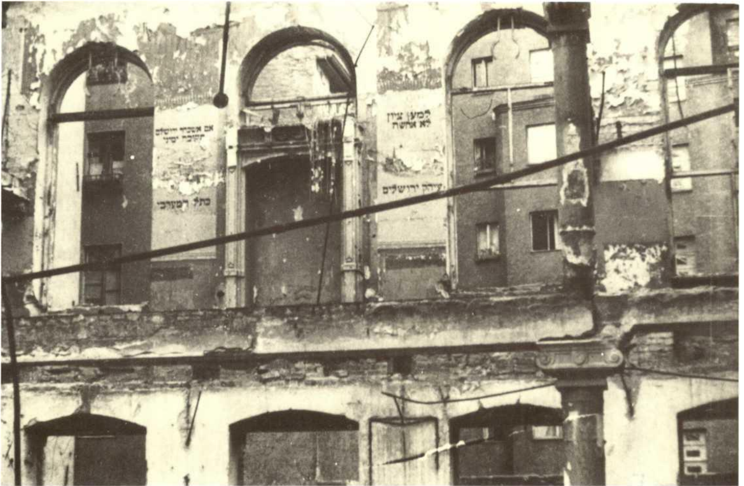
Ruine einer Synagoge in der Grenadierstrasse. Der Krieg hat die vorhergegangenen Zerstörungen durch die Nationalsozialisten kaum verschlimmert.
