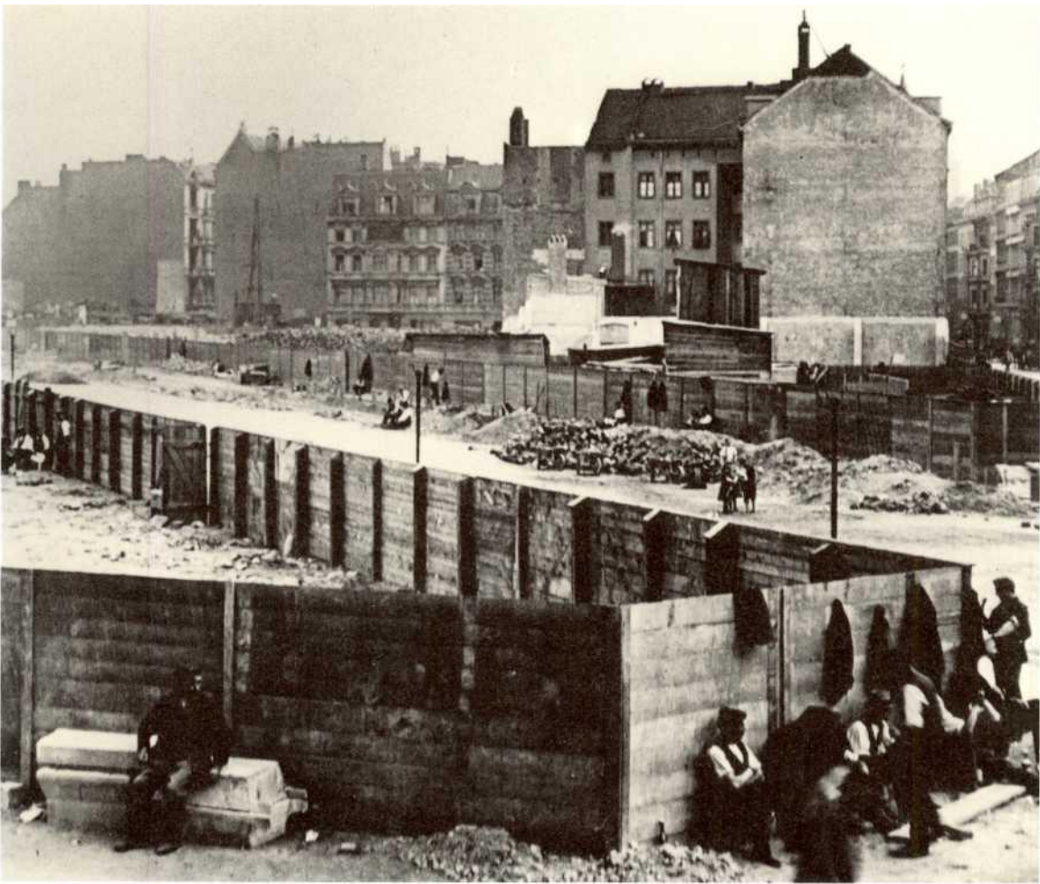
«... da gab es noch keinen Bülowplatz, keine Volks- bühne.» Abriss im Scheunenviertel 1906. Auf der freien Fläche wurde die Volksbühne errichtet.
