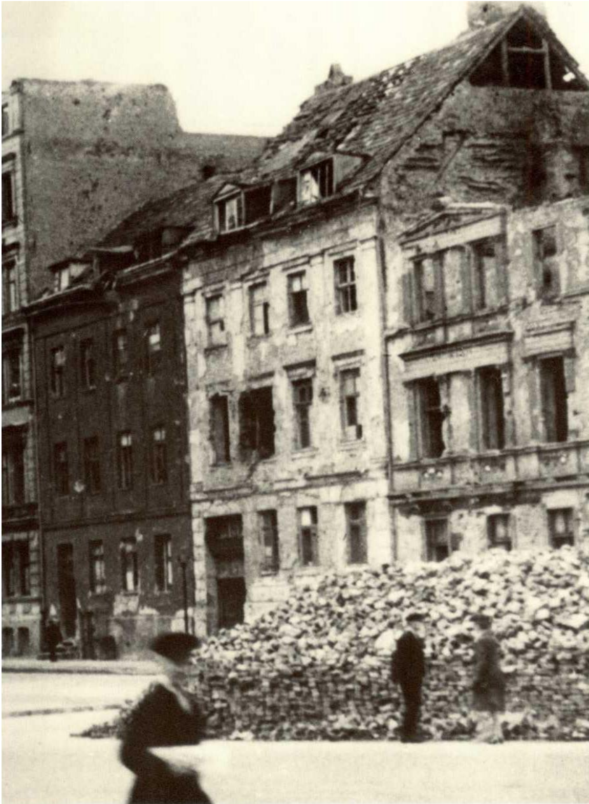
Das Scheunenviertel 1945. Zerstörungen Grenadier- Ecke Hankestrasse. Links eines der 1928 nach den Sanierungsplänen des Ar- chitekten Poelzig erbauten Häuser.
