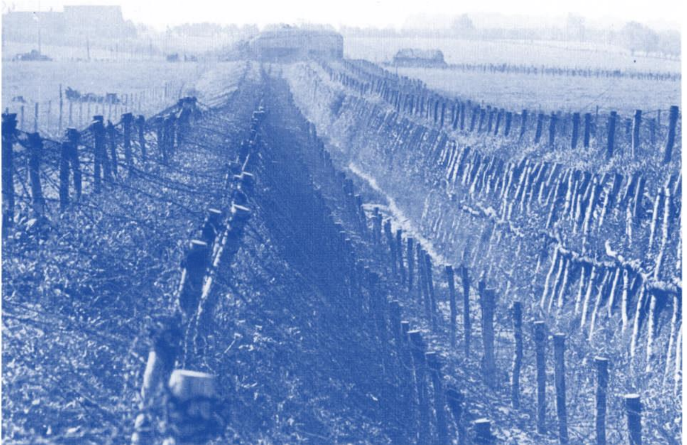
45 Panzergraben und Bunker der 1929-32 für 2,9 Milliarden Franc errichteten Maginot-Linie. Der Verteidigungsgürtel an der deutsch-französischen Grenze reichte von Longwy bis Basel.
