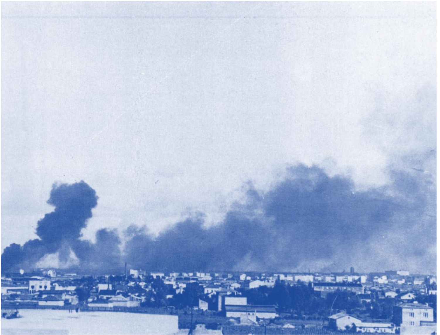
141 Von einem Hausdach an der Strasse Okecie-Warschau, 3 km südwestlich der Metropole, ist deutlich die Wirkung der Fliegerangriffe und des Artilleriefeuers zu erkennen. Grossbrände zehren die gequälte Stadt aus.
