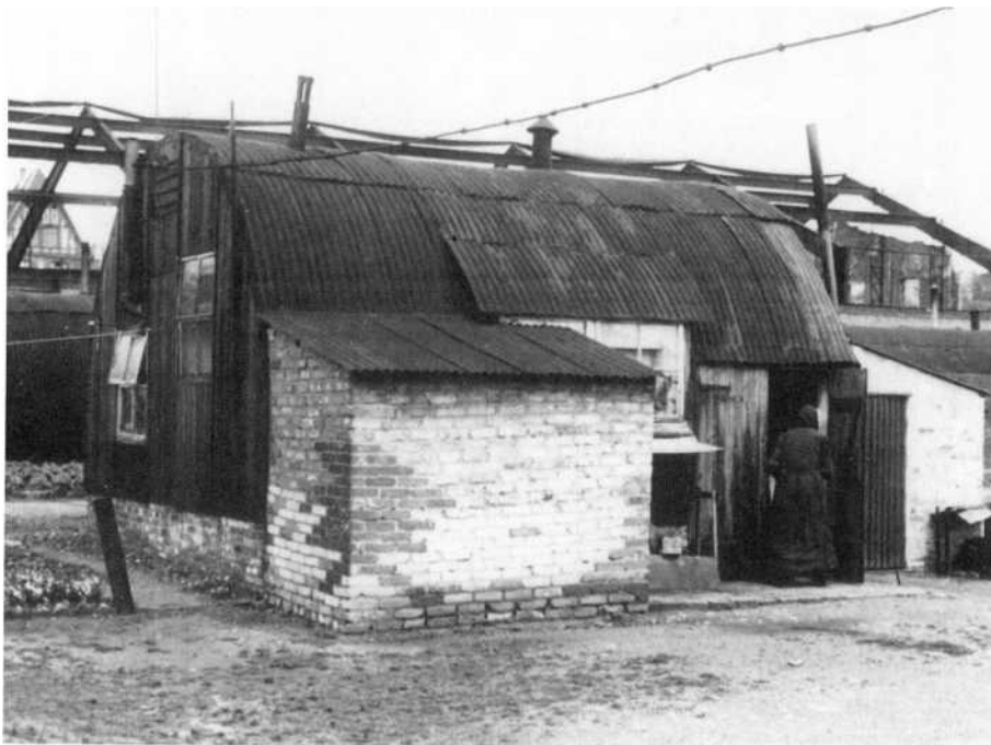
Dieses Kieler Nissenhüttenlager bestand aus 129 Wohn-, Abort- und Wirtschaftshütten. Die nach dem kanadischen Ingenieur Peter Norman Nissen benannten ‚nissen-huts‘ waren von der britischen Besatzungsmacht zur Verfügung gestellt worden. Die Nissenhütten hatten zumeist eine Gesamtwohnfläche von 40 qm und bestanden aus doppelwandigem Wellblech.
