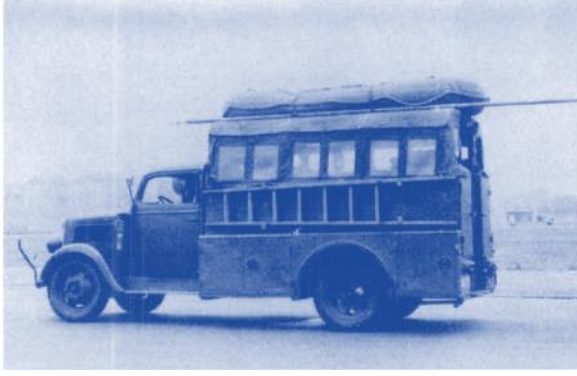
Wassernotfahrzeug, 1946/47. Auf der Basis eines Wehrmachts-Lkw von der Berufsfeuerwehr in eigener Werkstatt gebaut. Das Verdeck mit den Fenstern bestand aus Segeltuch-Zeltplanen der Wehrmacht.
