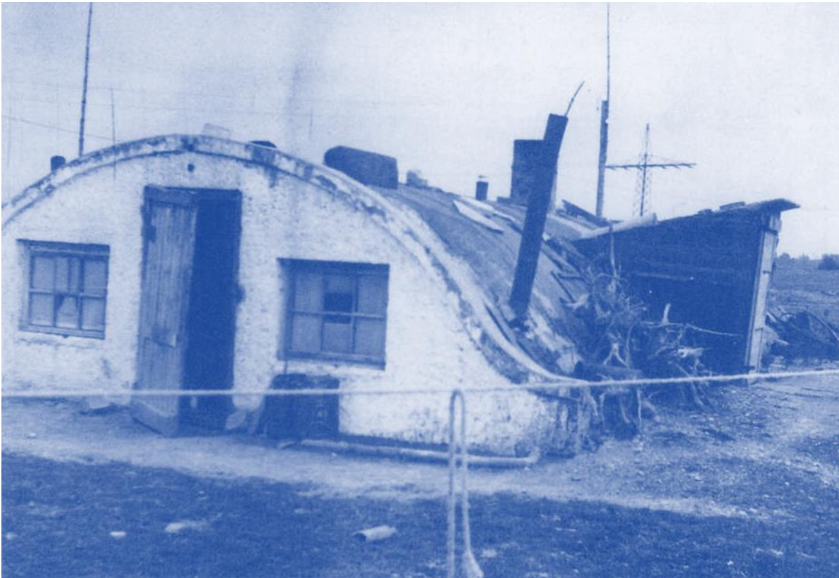
Unterkunft für die KZ Gefangenen des Aussenlagers Utting/Ammersee
