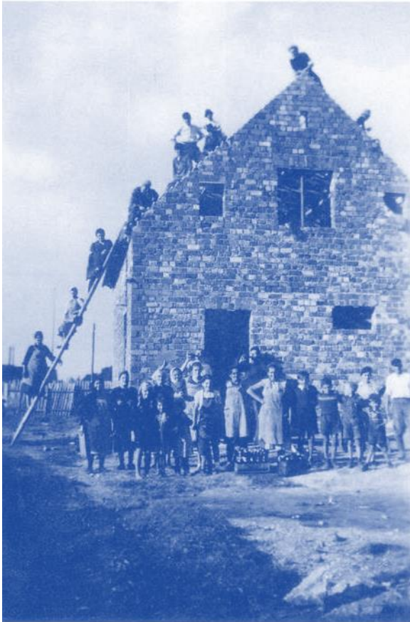
Das erste Haus wurde gebaut. Alle vom Lager – ob jung oder alt – halfen mit. Das ganze Haus ist aus Ausschusssteinen gemauert.
