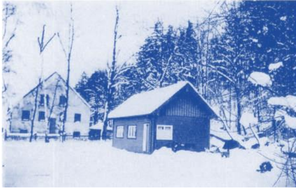
Das Gartenhäusl – eine Notunterkunft – daneben die ausgebrannte Waldgaststätte
