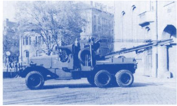
«Ami-Kran» – im Einsatz ab ca. 1947 bis Ende der 50er Jahre. Er wurde der Berufsfeuerwehr München von der Besatzungsmacht überlassen und später umgebaut.
