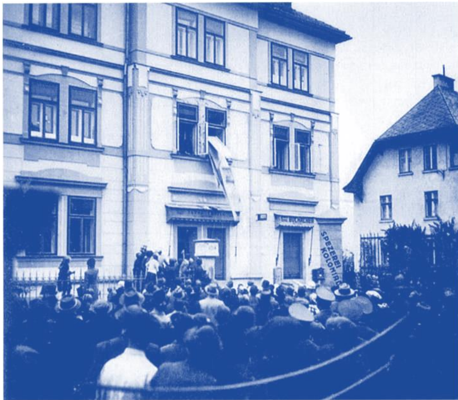
Die Aufnahme aus dem Nachlass von Dr. Walther Fresacher zeigt die Demolierung der Wohnung von Dr. Egon Weissberger in der Peraustrasse 33, Villach, 10. November 1938. Foto: Kärntner Landesarchiv, Klagenfurt
