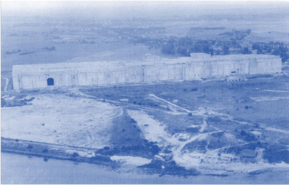
Luftbildaufnahme des Bunkers von 1951. Dieses Foto ist auch auf der Eingangstafel der Ausstellung zu sehen.
