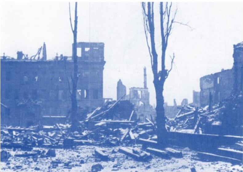
81 Fassadenrest des Rathauses von der Winklerstrasse aus gesehen – dahinter lag der von Dürer und seiner Schule ausgemalte, nun vollständig ausgebrannte Grosse Ratssaal.
