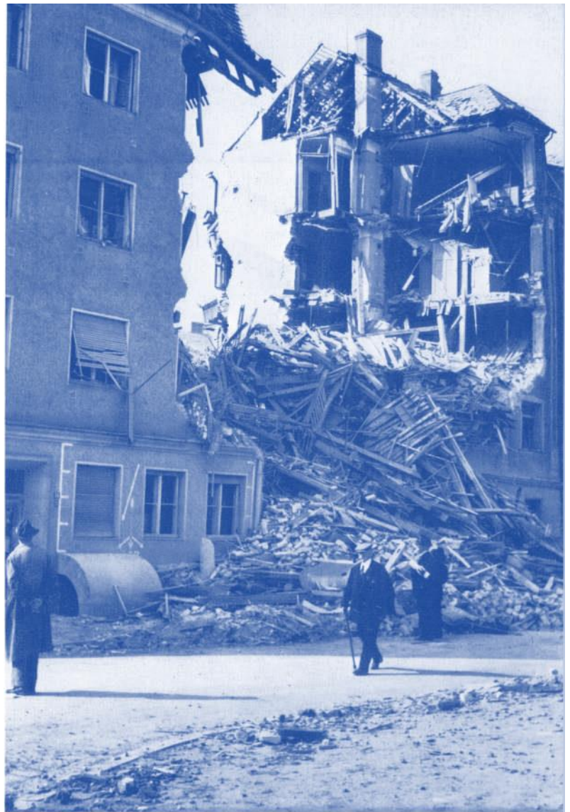
57 Markierungen an den Aussenwänden sollten auf die Lage der LS-Keller und Notausgänge hinweisen und Bergungskräften bei der Suche nach Verschütteten die Arbeit erleichtern. Kellerfenster, die als Notausstieg vorgesehen waren, erhielten zusätzlichen Schutz aus Beton oder Mauerwerk.
