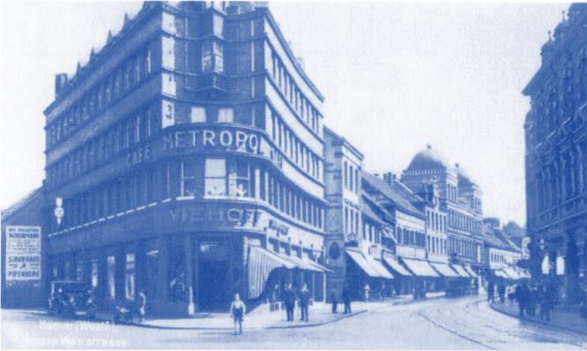
18. Blick in die Grosse Weststrasse in Hamm, ca. 1930. Der expressionistische Backsteinbau des ehemaligen Geschäftshauses Lommel wurde 1927 errichtet. Das Café Metropol im ersten Stock war ein beliebter Treffpunkt zu jener Zeit.
