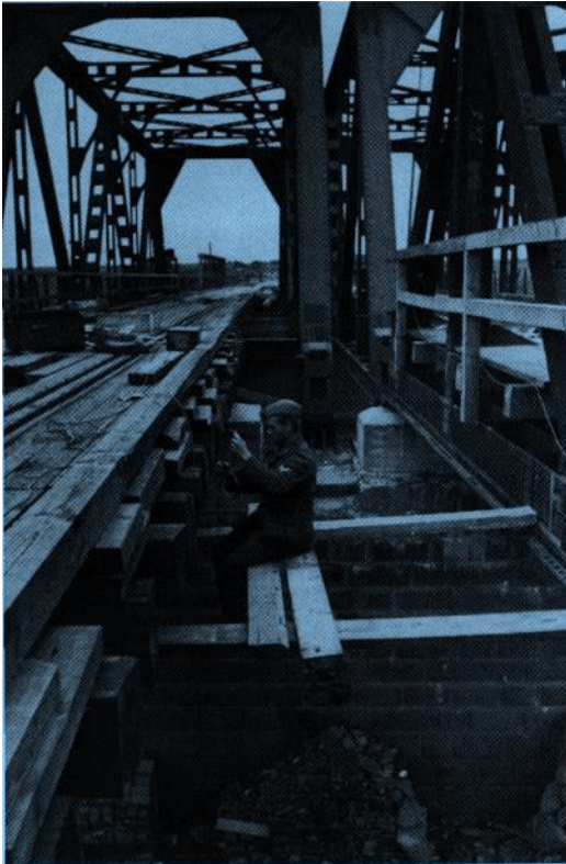
Vorbereitung einer Brücke zur Sprengung.
