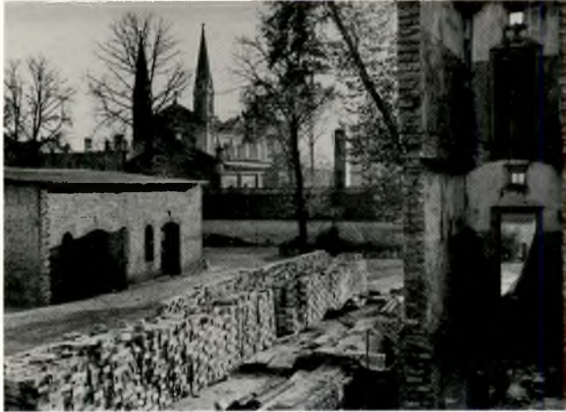
Kirche der Strafanstalt und Gebäude der Richtstätte (links), im Vordergrund das zerstörte Haus III, das »Totenhaus«, nach 1945
