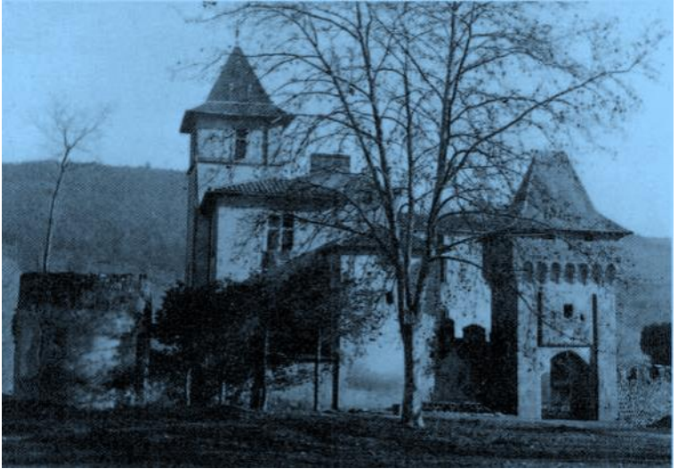
Bild 3: Der Eingang zum Schloss. Beim zerfallenen Turm rechts der Treppenturm.
