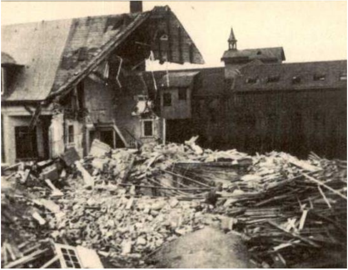
Nach englischem Bombenabwurf am 26. März 1944 zerstörtes Haus an der Mettmanner Strasse in Wülfrath (Privatarchiv: E. Jansen)
