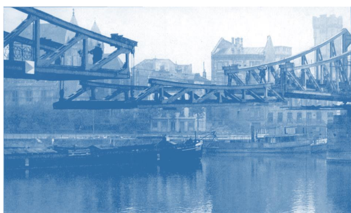
20. August 1946, 7 Uhr früh. Das letzte Teilstück für den wiedererstandenen Eisernen Steg wird eingefahren.
