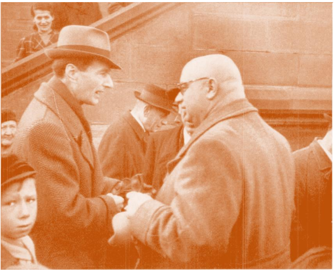
Jedes Richtfest war ein Ereignis. Oberbürgermeister Walter Kolb und Rundfunkintendant Beckmann bei der Einweihung des Eisernen Stegs.
