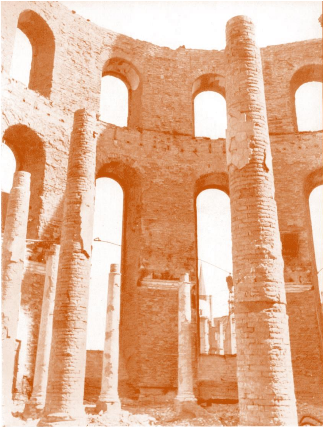
In der gespenstischen Ruine der Paulskirche ragten die Säulen wie tote Schornsteine gen Himmel.
