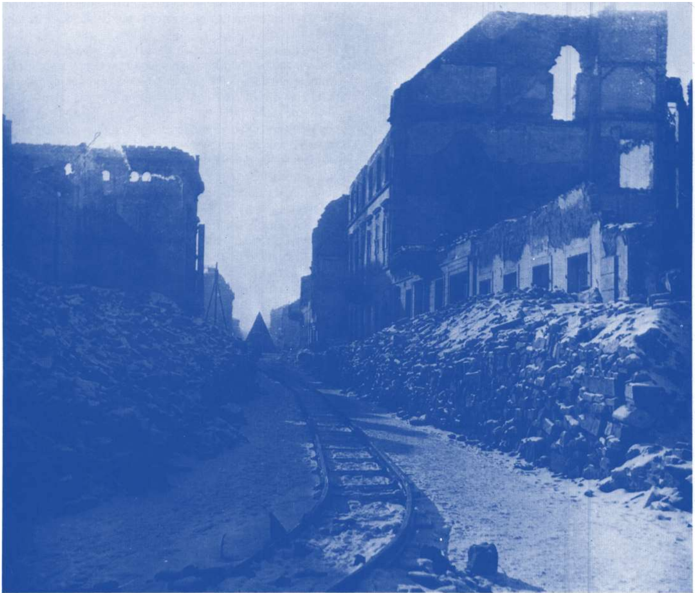
Zubringergleis vom Marktplatz zum Schlossplatz, wo der «Bahnhof» für den zum Rheinhafen führenden «Schuttexpress» eingerichtet wurde.
