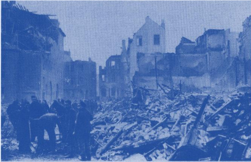
Italienische Kriegsgefangene (Alpini) bei Entrümmungsarbeiten in Bremen, 1943/44
