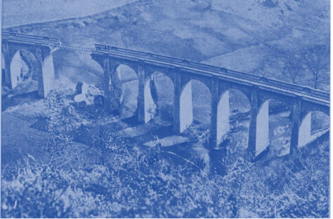
Viaduc de Bussy-Varache (Eymoutiers, Haute-Vienne), après la destruction de l'une des piles par Georges Guingouin et ses maquisards, le 13 mars 1943.
