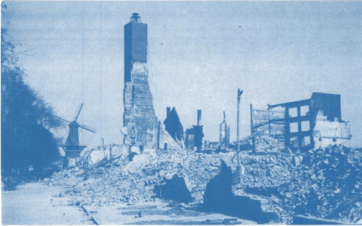
Die Ruinen von Hertzbergers Bekleidungsfabrik nach dem Bombenangriff auf Rotterdam 14. Mai 1940.
