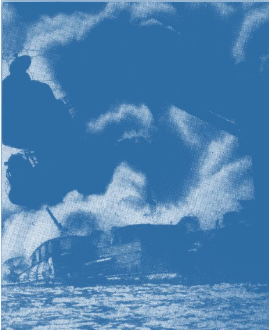
Die «Arizona» sinkt brennend. Eine japanische Bombe war durch einen Entlüftungsschacht bis in eine Munitionskammer gedrungen und hatte eine Explosion verursacht, die das Schiff zerriss
