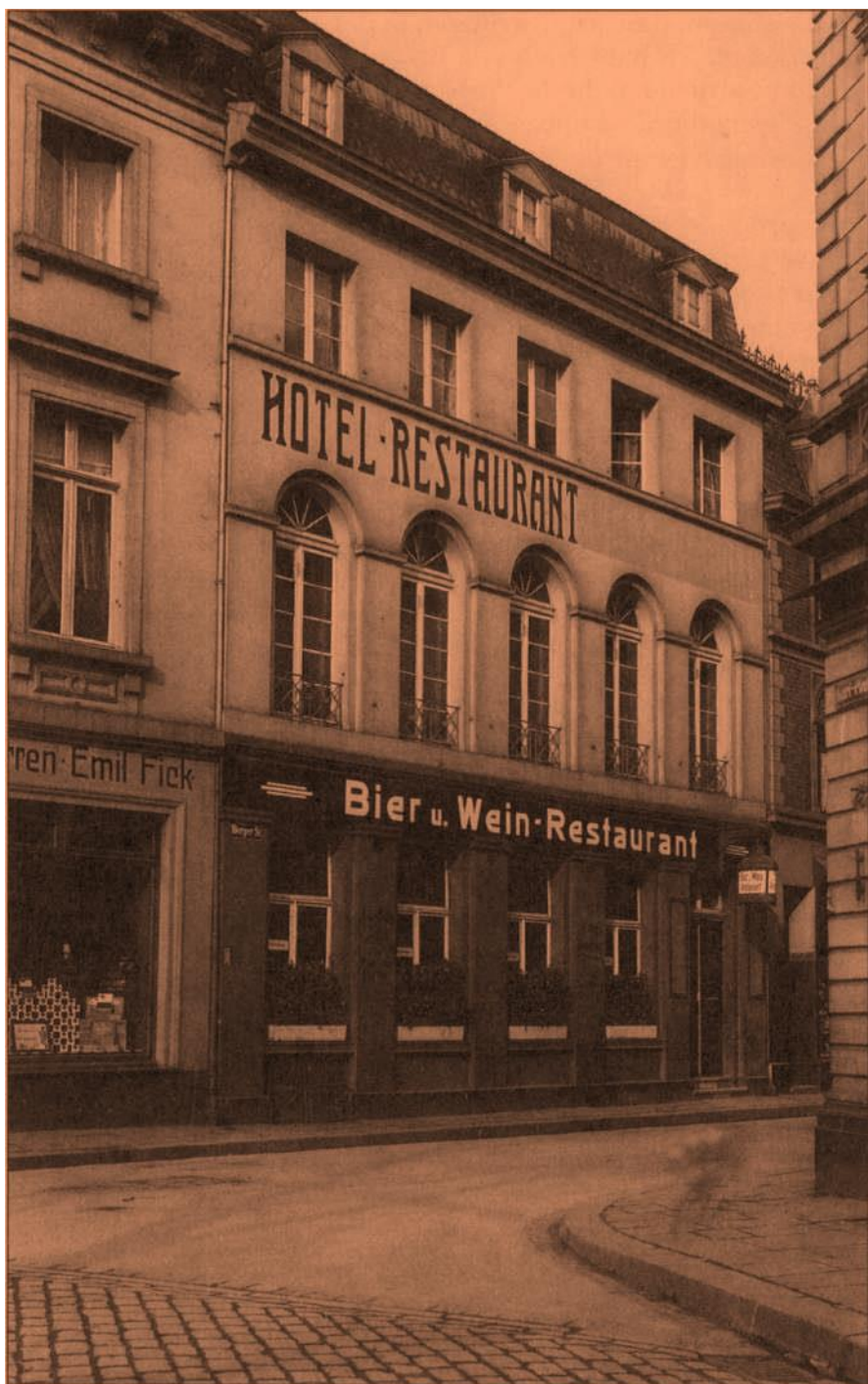
Die Gaststätte «Arcari» auf der Bergerstrasse (1913)
